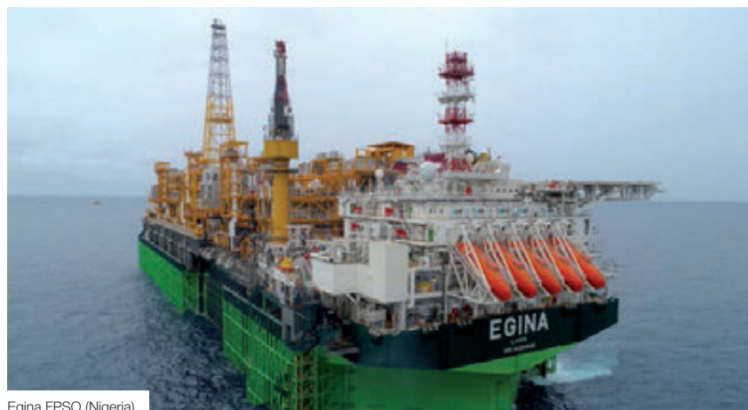
Egina FPSO (Nigeria)
