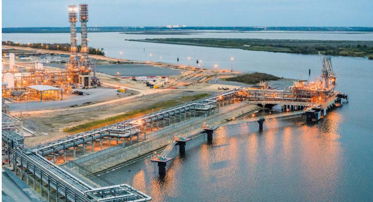
Cameron LNG liquefaction terminal, Louisiana, U.S.A.
