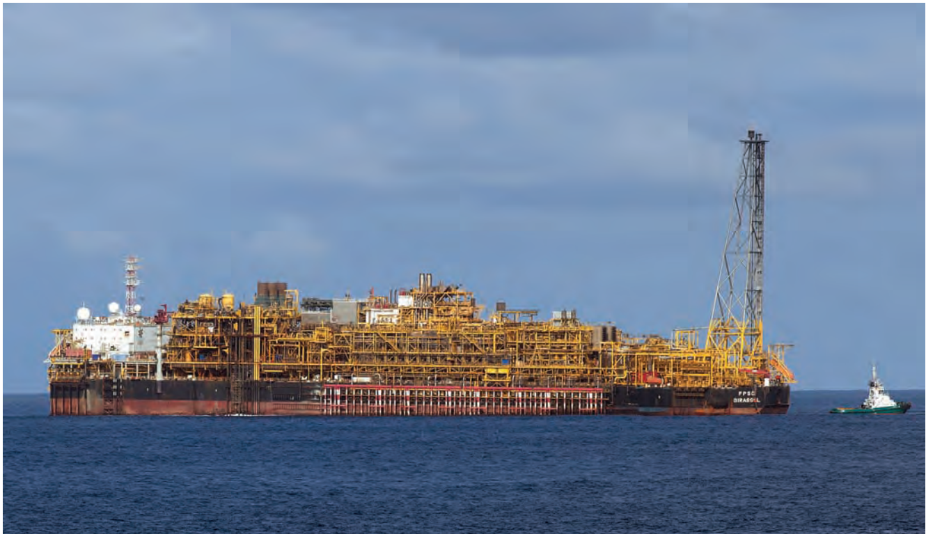
FPSO - unité flottante de production, stockage et déchargement - du projet CLOV, Angola.
