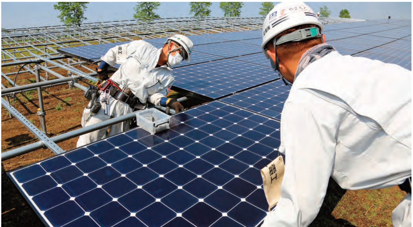
Chantier d'installation de panneaux solaires Sunpower chez Sasyunkan co, Kumamoto, Japon.
