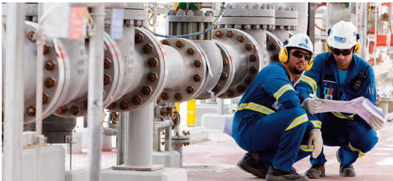
Opérateurs extérieurs sur la raffinerie Satorp à Jubail, Arabie Saoudite.
