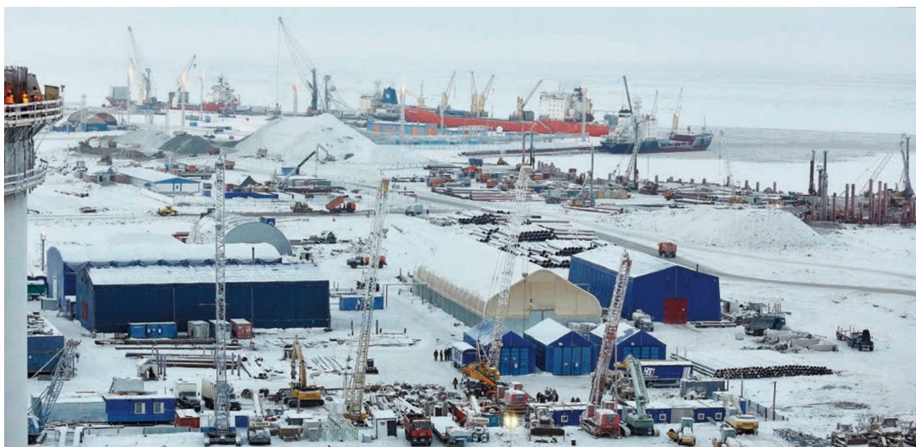
Station de production de gaz naturel liquéfié Yamal, Russie.
