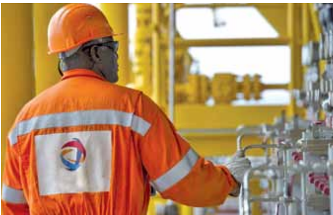
Plate-forme au large de Port Gentil, Gabon.
