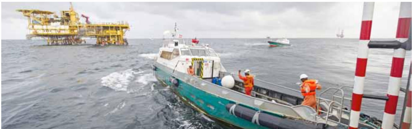
Plate-forme au large de Port Gentil, Gabon.
